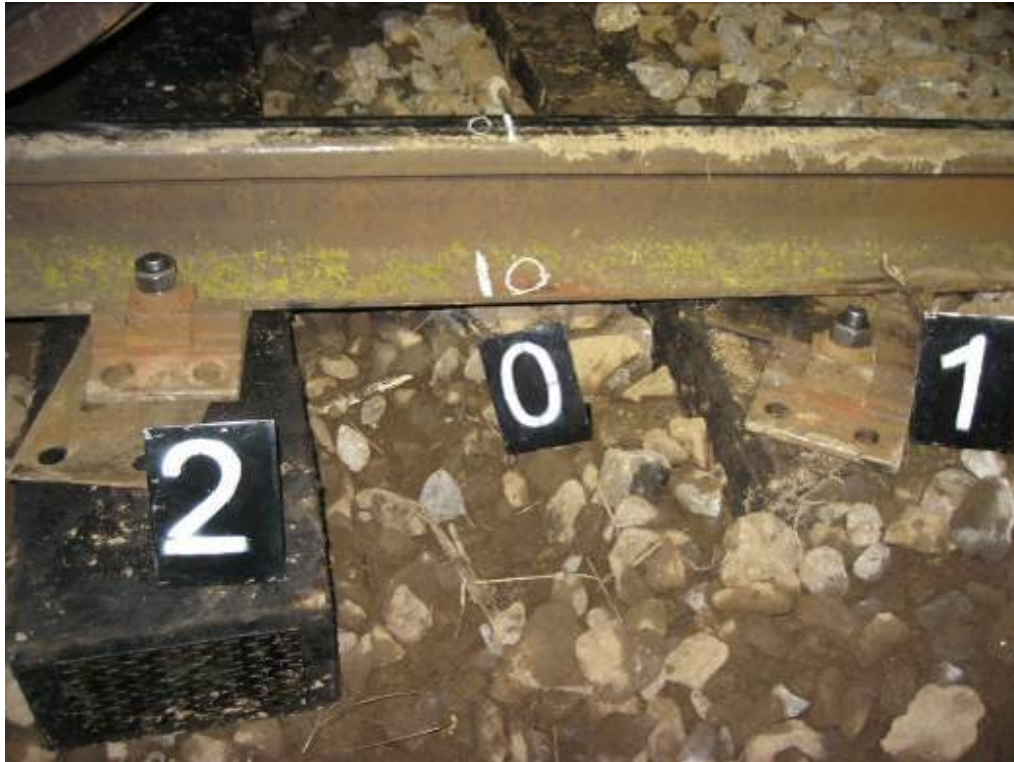
Foto nr.2 – detaliu punct „0” de cădere între firele căii
