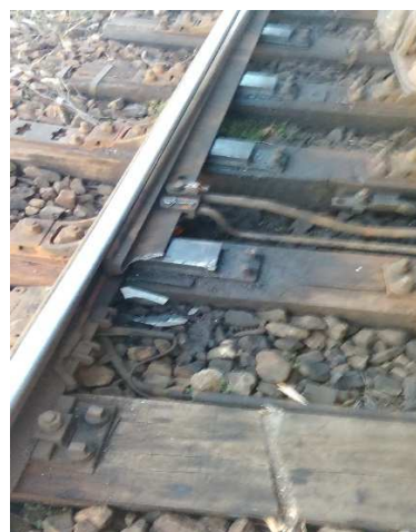
Fotografia nr.15 - Acul drept al schimbătorului de cale nr.41, care a fost lovit la vârf de roata nr.2
