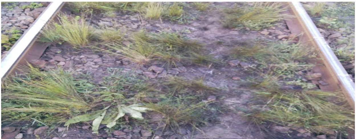
Foto.7 - traversele în zona punctului „0”
