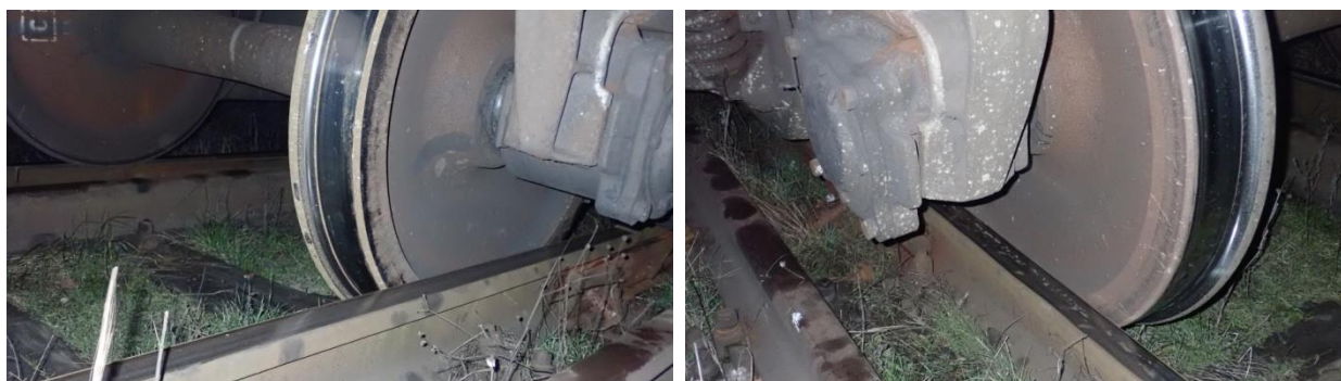
Foto nr.4 - vagonul nr.67846618 - după deraiere
