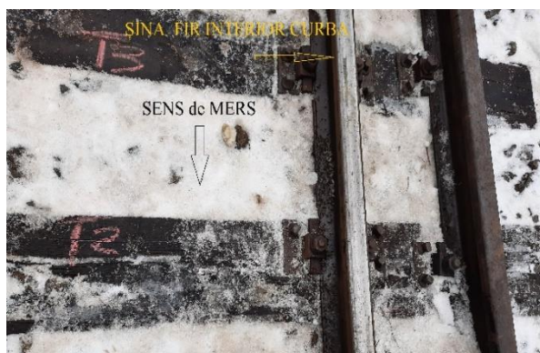
Imaginea 14 – traversa „T 2 ” zona spre fir interior
