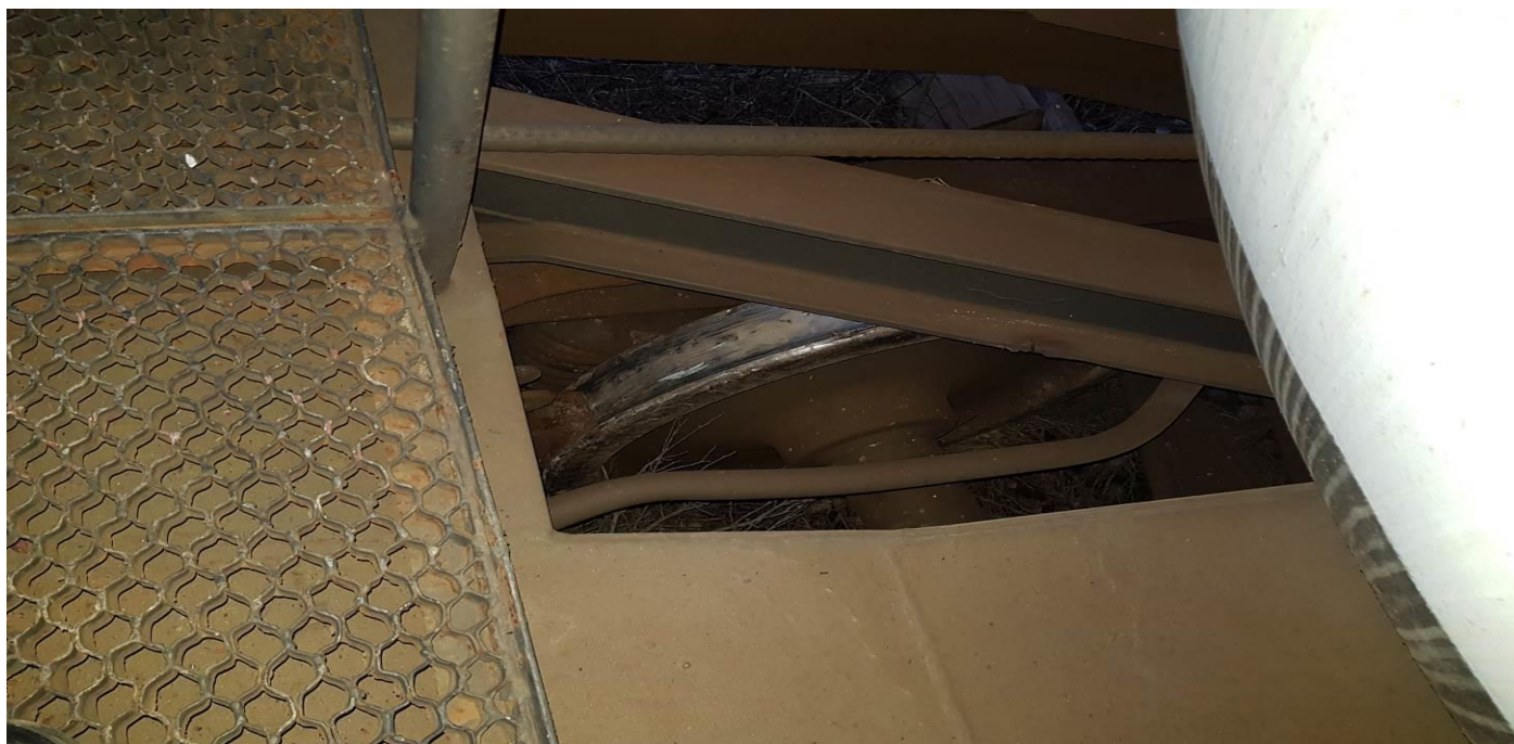
foto 7,8: urme de lovire pe suprafața de rulare a roților deraiate
