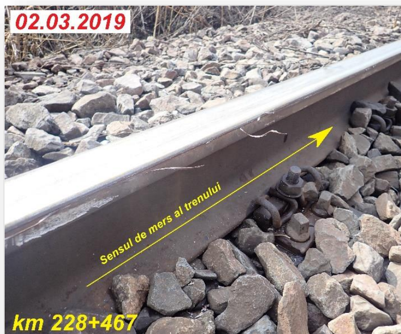
Foto nr. 3 - Urmă produsă de fața laterală exterioară a bandajului roții din stânga osiei nr.6
