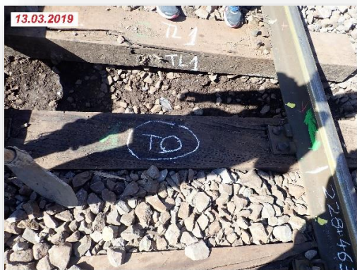
Foto nr.6 – Traversa T_0 în cale
