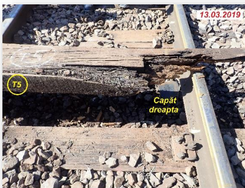
Foto nr.10 -Traversa T 5
