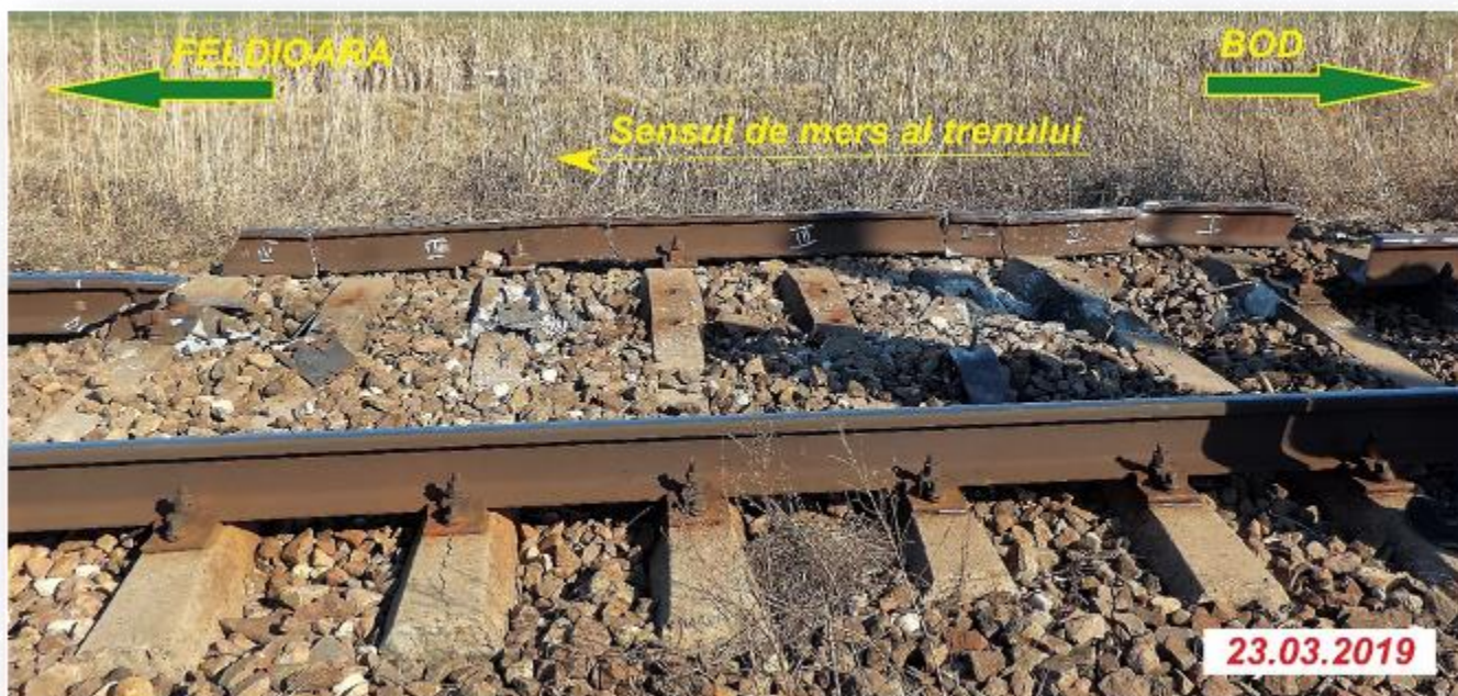
Foto nr.6 – Reconstituirea șinei cu ruperi multiple
