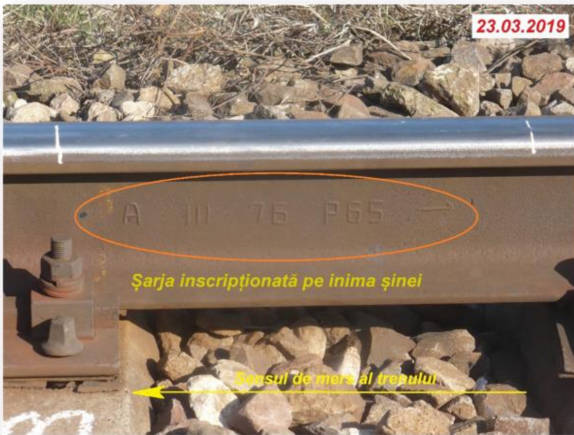
Foto nr.4 - Șarja inscripționată pe inima șinei cu rupere multiplă
