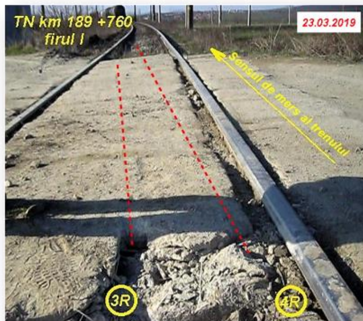
Foto nr.1 – Urmele produse de roțile 3R și 4R ale boghiului deraiat după escaladarea dalelor de beton interioare ale trecerii la nivel
