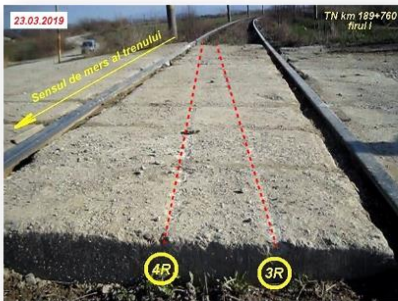
Foto nr.2 – Urmele produse de roțile 4R și 3R ale boghiului deraiat după escaladarea dalelor de beton interioare ale trecerii la nivel
