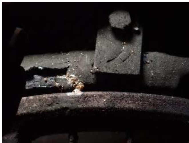
Foto nr.3 punct de arc electric pe bara de înseriere
