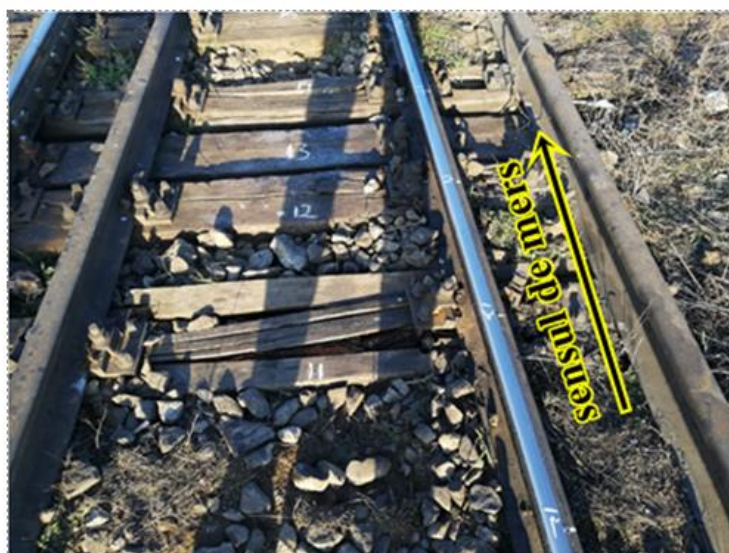
Fig. nr.5 – starea tehnică a traverselor
