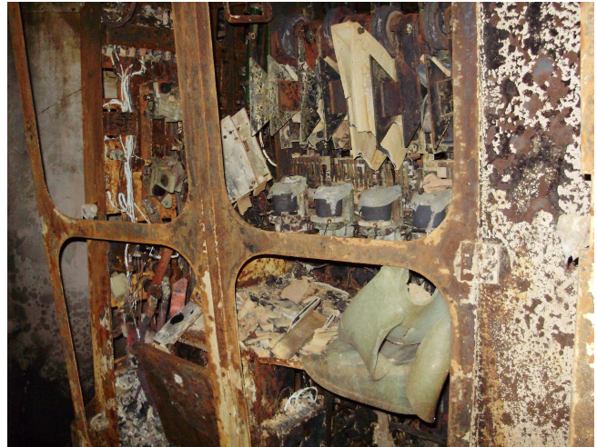
Bloc aparate – contactori de linie MT (foto.8)
