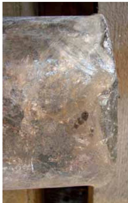
Photo 2 : vue du corps aux abords de la rupture de l'essieu côté droit.
