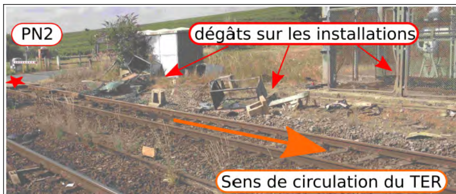
Figure 54 : visualisation des accumulateurs heurtés par le véhicule suite au choc (photo SNCF, légendée BEA-TT)
