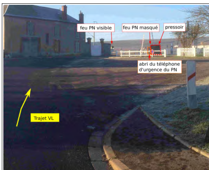
Figure 63 : illustration des enjeux de visibilité à 60 m en amont du PN dans le sens de circulation du VL impliqué, demi-barrières levées (photo et légende BEA-TT)
