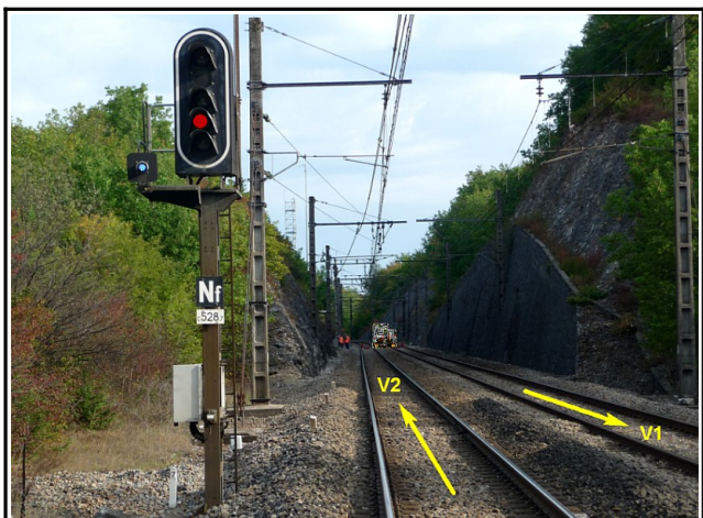
Vue 2 - La voie 2 au niveau du signal implanté au PK 528,705 avec le chantier 200 mètres plus loin.
