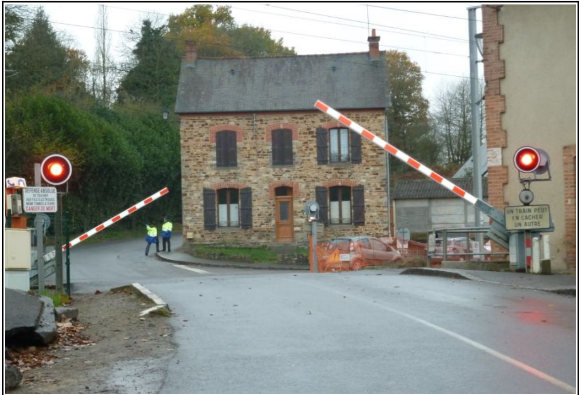
Figure 3 : Le passage à niveau n°11 dans le sens de circulation emprunté par l'ensemble routier accidenté, au moment de l'abaissement des deux demi-barrières
