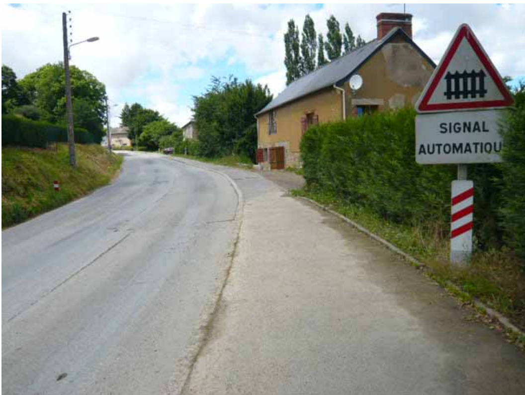
Photo 4 : Accès au passage à niveau en venant de Saint-Médard-sur-Ille. La vitesse est limitée à 50 km/h.
