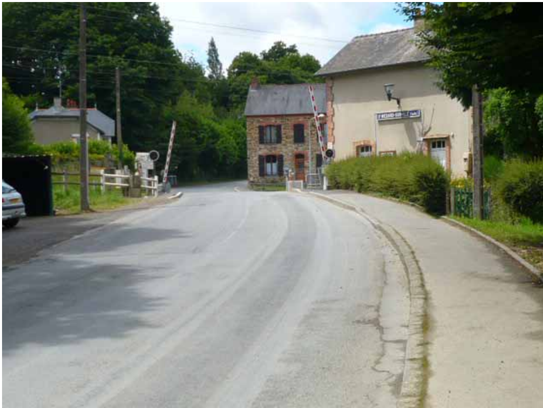
Photo 5 : Le passage à niveau en venant de Saint-Médard-sur-Ille. Le feu tricolore de chantier était implanté le long du trottoir droit
