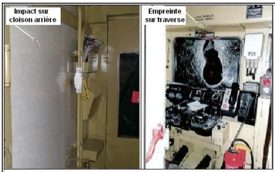
Figure 27 : Traces dans la cabine de la Z 6155
