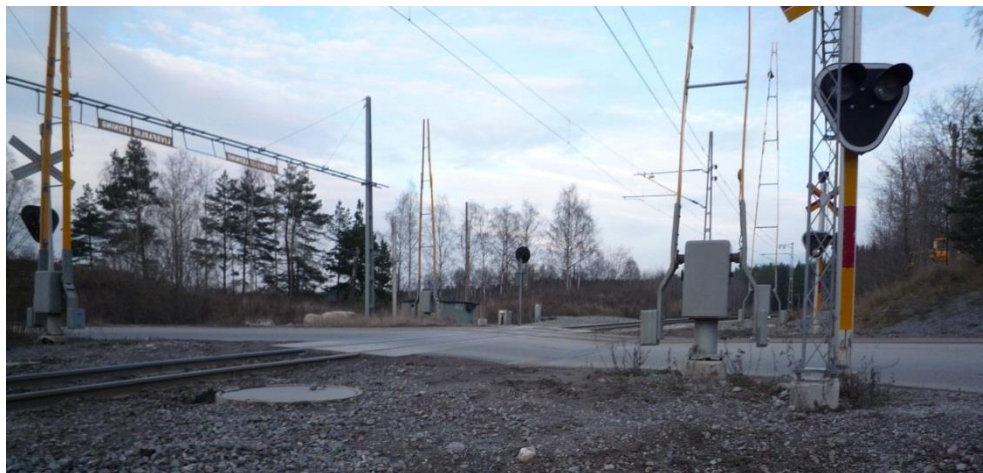
Figur 7. En bild där svackan söder om spåren, mellan bommen och högra rälen, tydligt framgår. Foto: SHK.
