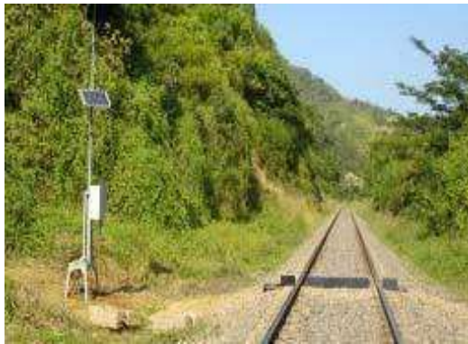
Abbildung 69 Ortfester Entgleisungsdetektor - Quelle Vossloh America
