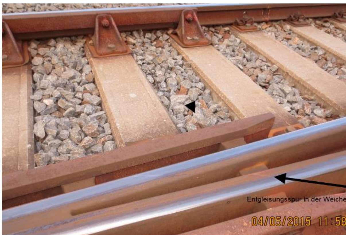
Abb. 1: Aufnahmen an der Unfallstelle
