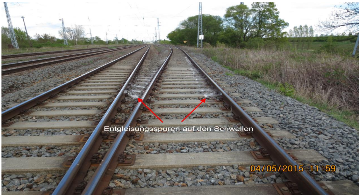
Abb. 9: Trümmerspuren durch den aufgeschlagenen Spurkranz auf den Schwellen
