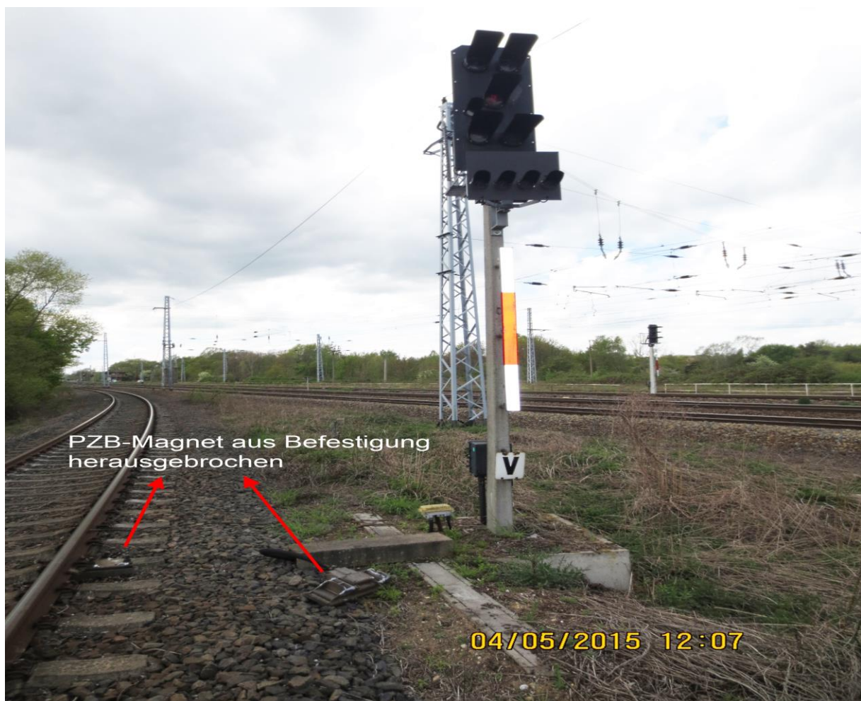
Abb. 3: Beschädigter PZB-Magnet
