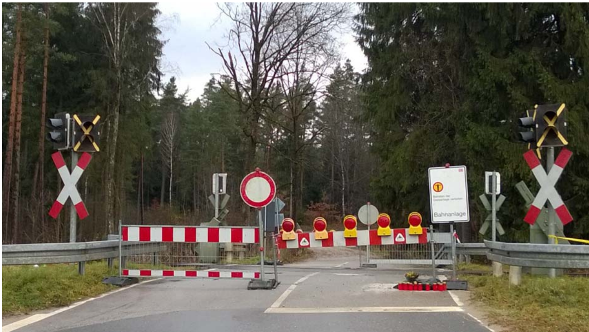
Abb. 10: Detailansicht der Kuppe vor dem BÜ mit Fahrbahnverwindung
