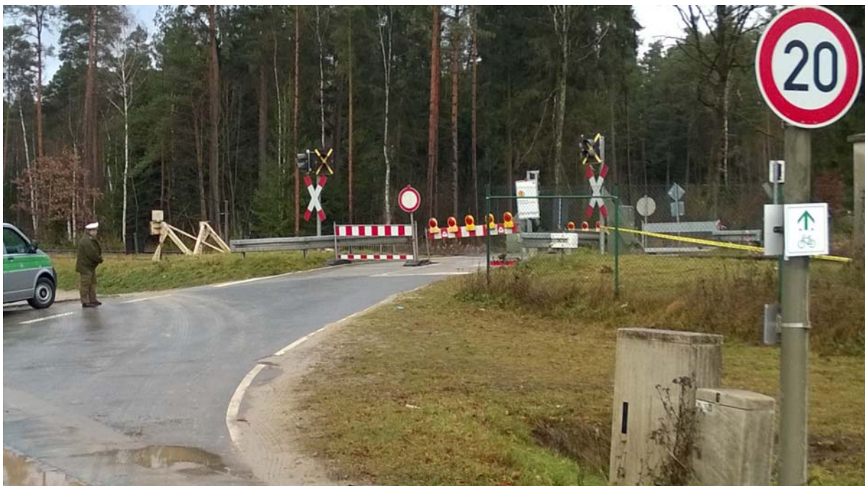
Abb. 9: Nahansicht mit Fahrbahnverwindung zur Kuppe vor dem BÜ
