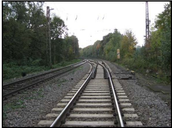
Abb. 17: Weichen 1 und 2, Blickrichtung Bottrop
