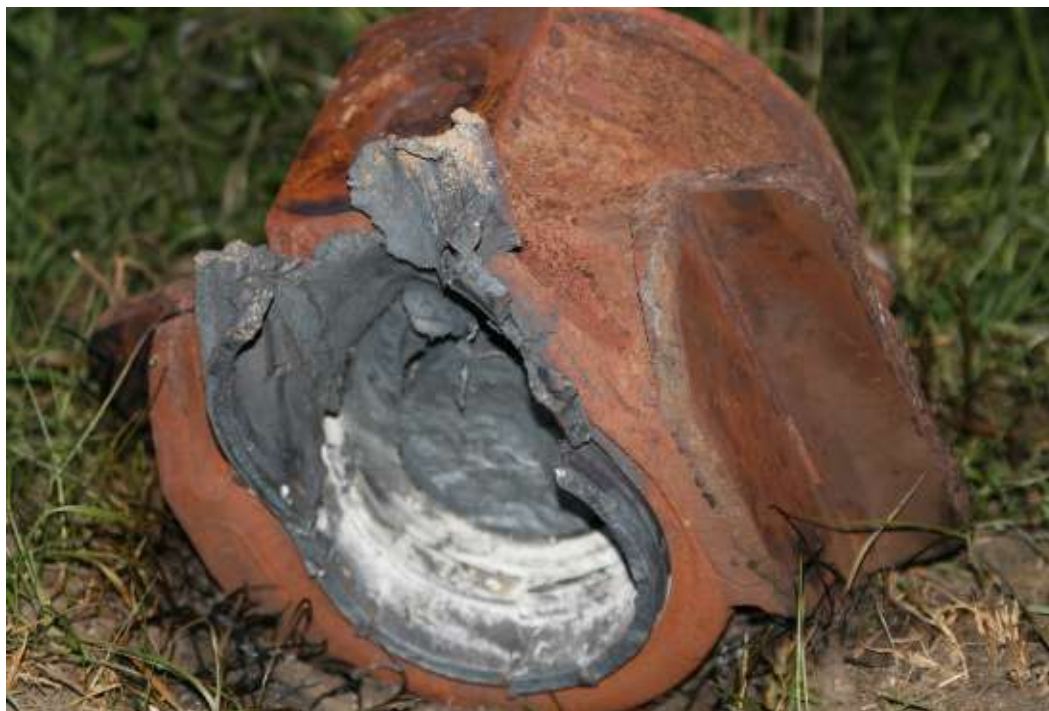
Obr. č. 6 : Detail tohoto ložiskového domku
