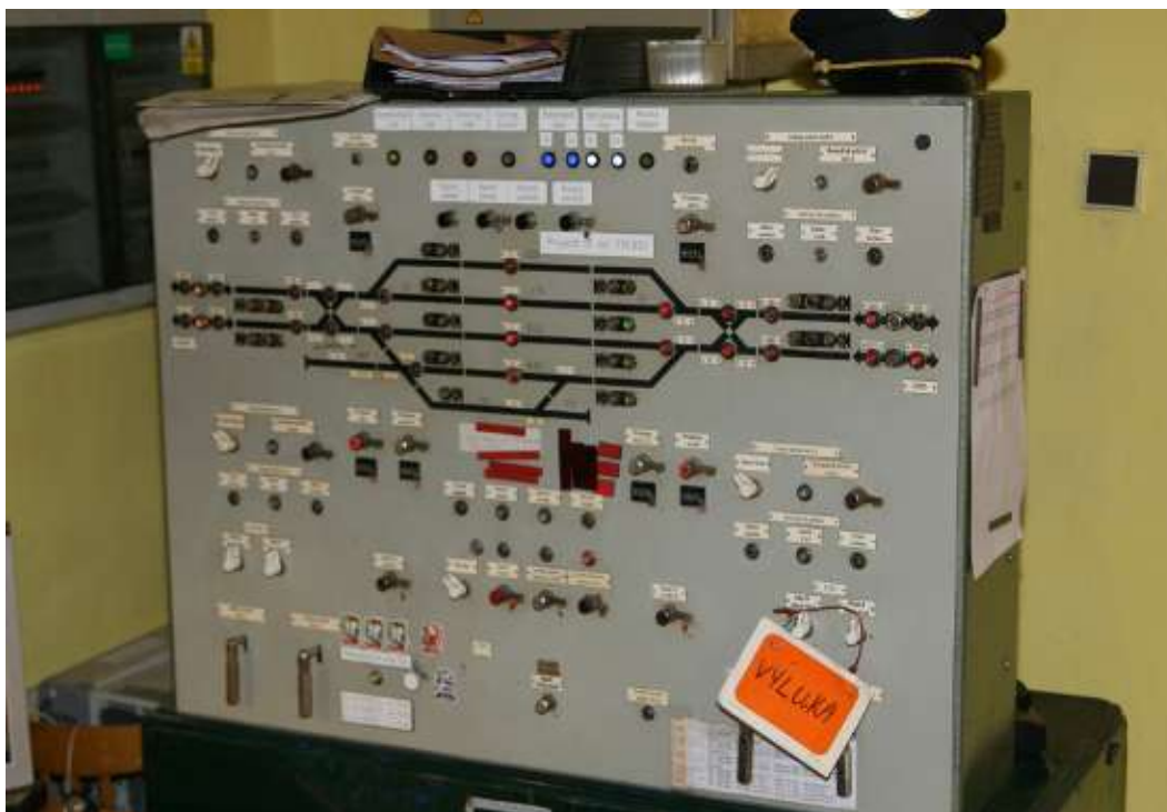
Obr. č. 11: Stav staničního zab. zař v době příchodu pověřených osob
