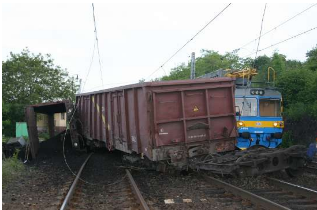
Obr. č. 4: Pohled na skupinu poškozených TDV od konce vlaku
