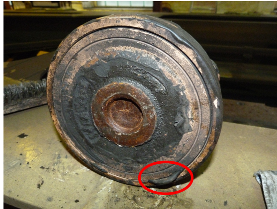
Valve de pesée où des dégâts consécutifs à l'accident sont visible (joint d'étanchéité sorti).
