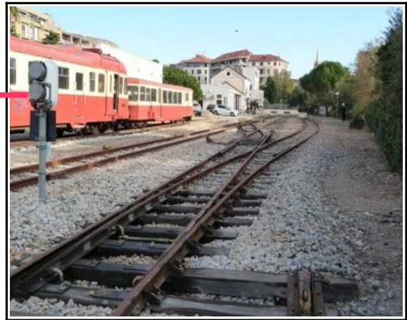
Le signal d'arrêt n°4 vu de dos et les aiguilles E, F et G
