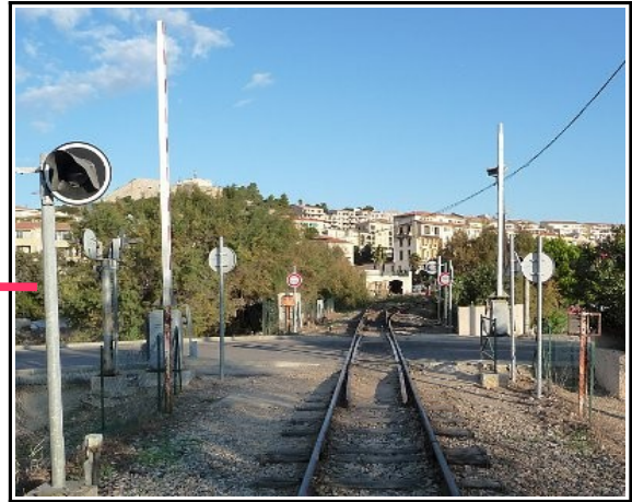
Le signal de contrôle de fermeture des barrières du PN n°26A
