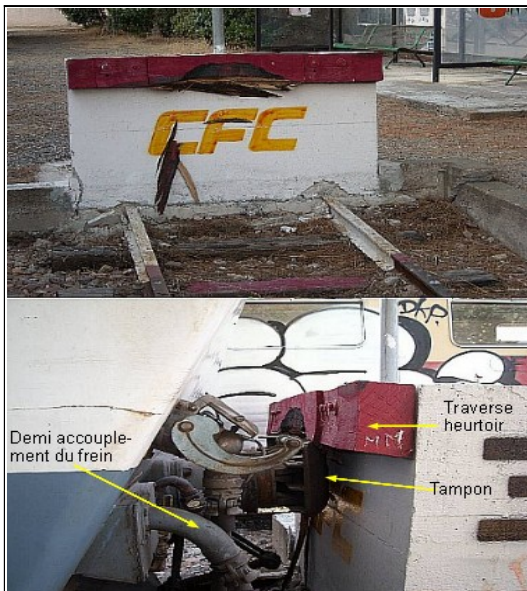
Figure 2 - Le heurtoir de la voie 3/C et le train n°317 après l'accident
