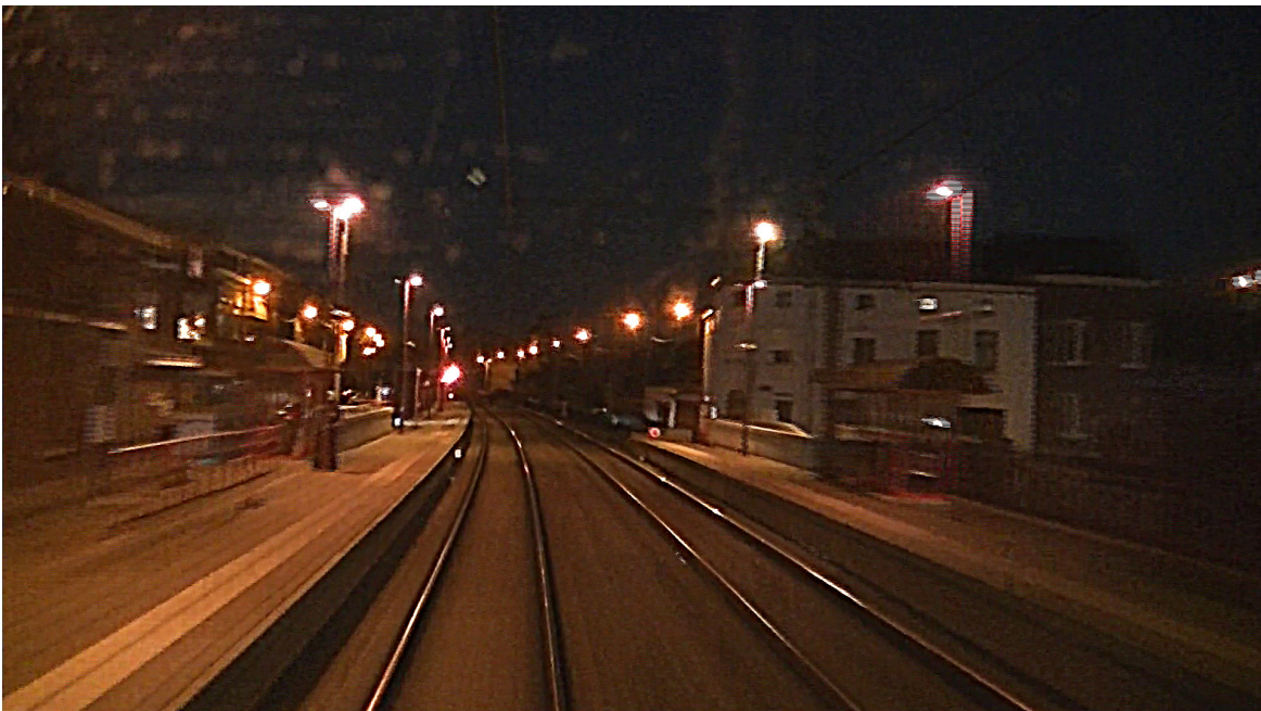
Illustration : visibilité et saillance du signal D.11 à l'extrémité des quais de Amay - A noter que la performance de la prise de vue est moins bonne que celle de l'œil humain.
