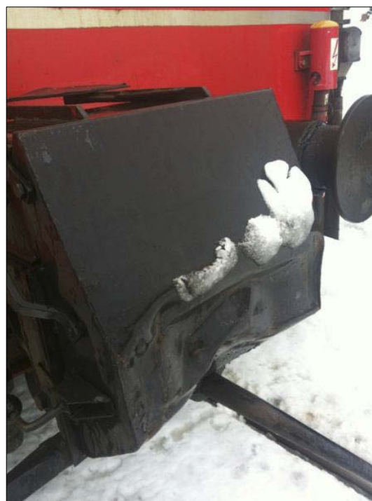
Figur 8: Nærbilde av skade (kilde: NSB).
