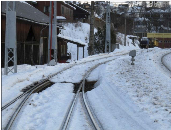
Figur 5: Spor 18 opp mot lokstall (kilde: SHT).
