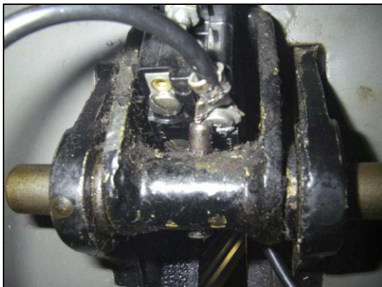
Figur 4: Skadet kabelsko.
