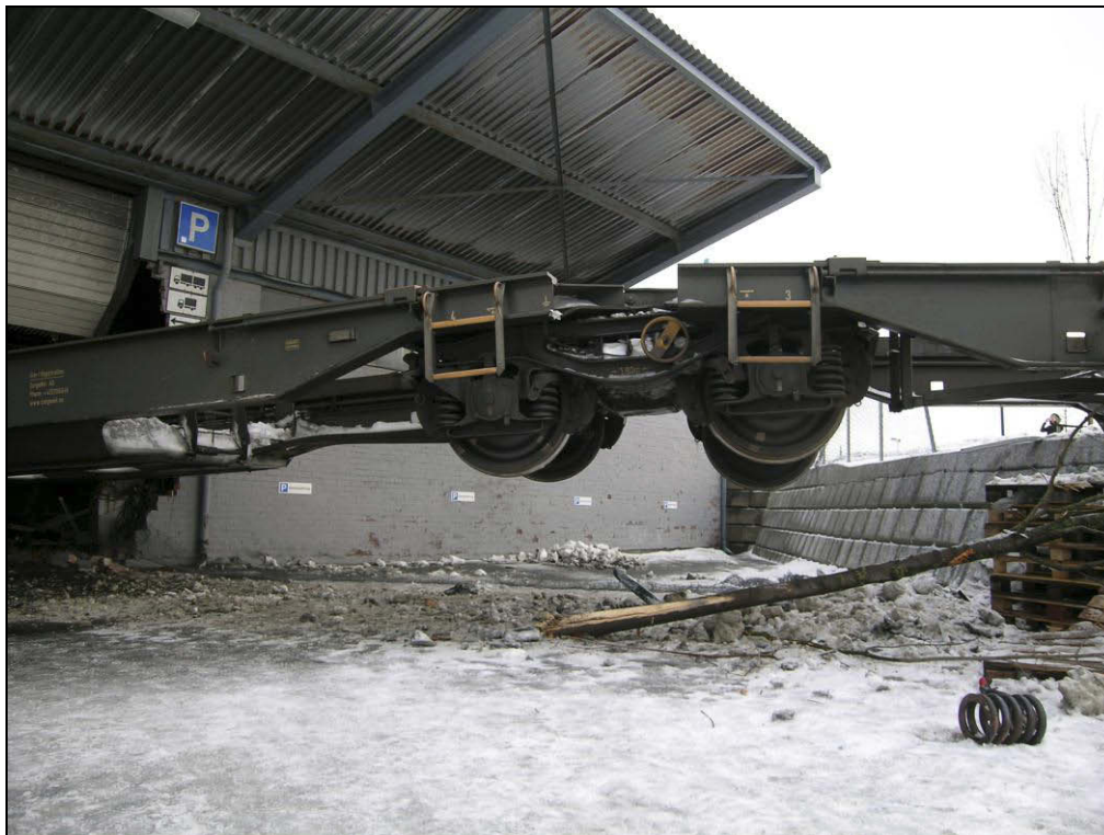
Figur 3: Viser vognen inn i lagerbygningen.
