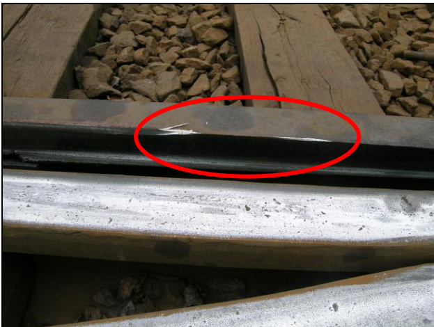
Figur 3: Viser avspøringsmerket i sporveksel 3 hvor den første boggien i vogn 1 gikk av sporet.
