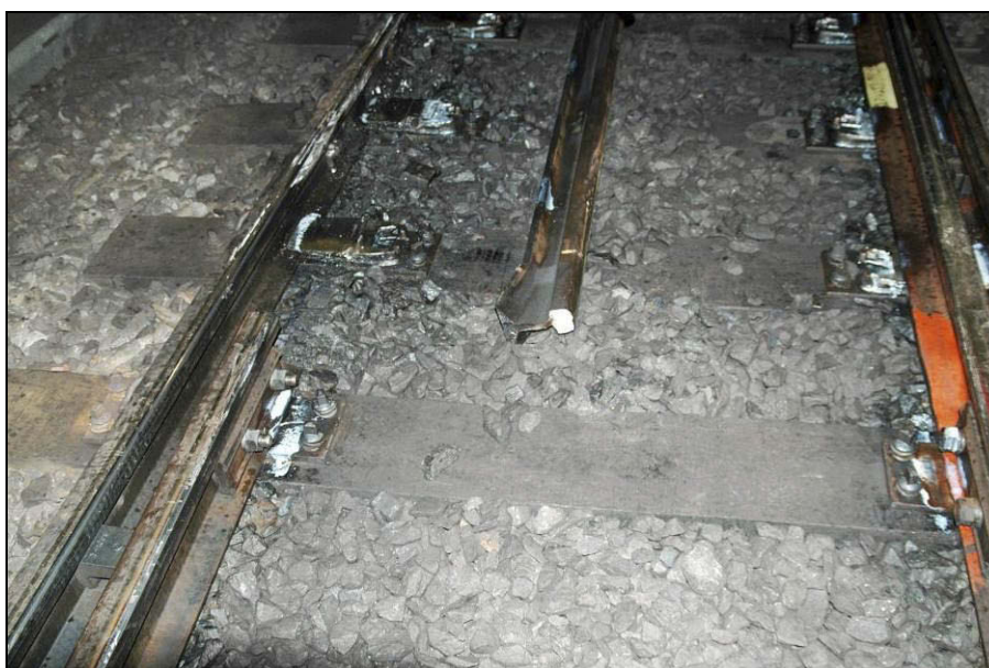
Figur 4: Skinnebrudd i tunga på sporveksel 265 på Tøyen -retning vest.
