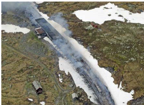
Figur 37: Oversiktsbilde av Hallingskeid etter brannen.
