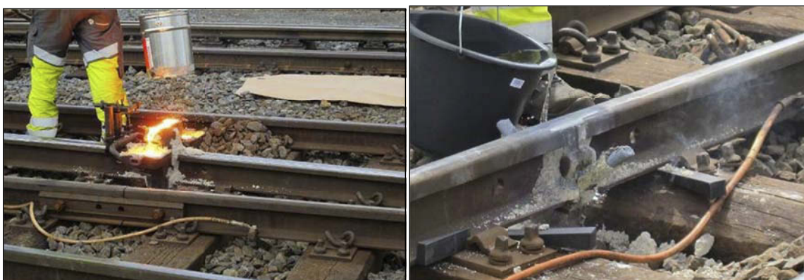
Figur 42 og 43: Fjerning av thermitbøtte og slukking av røykutvikling i tresviller.
