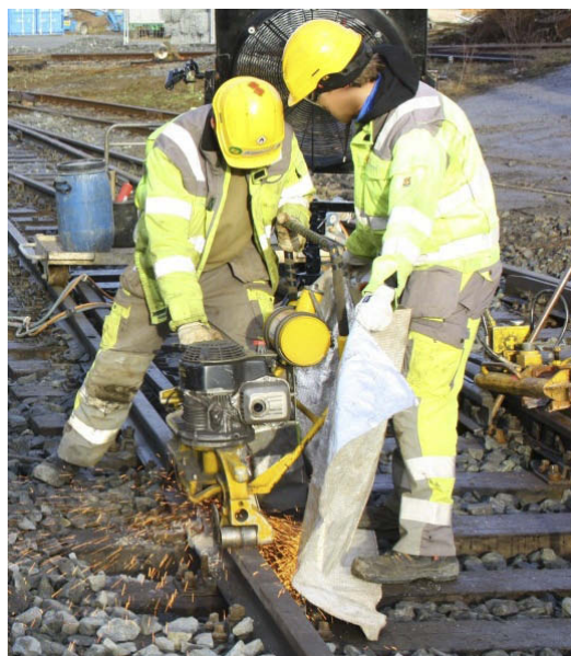
Figur 3-10 Sliping med bruk av sveiseduk (Skien). Vindmaskinen synes i bakkant av sveiserne.
