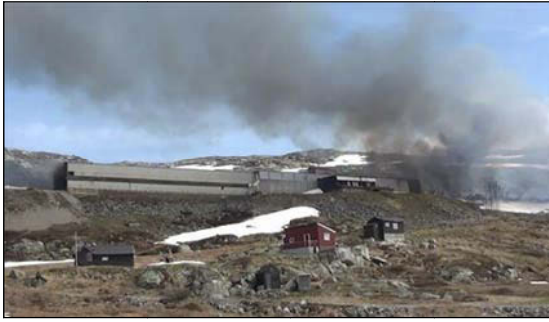
Figur 15: Kl. 12:20 Bilde fra samlingsplassen hvor passasjerene ble evakuert. Det kommer nå røyk ut fra åpningen på snøoverbygget på vestre side av stasjonsbygningen. Dette tyder på at brannen er i ferd med å spre seg til vestre snøoverbygg. (Kilde: Rob van Haaren)
