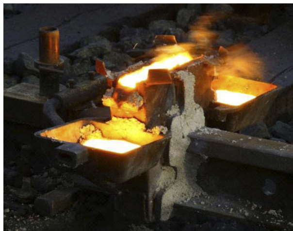
Figur 5-8 Flytende varmt materiale fra termitt-sveis.
