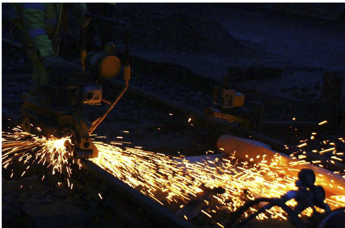
Figur 5-6 Oppsamling av metallpartikler under slip.
