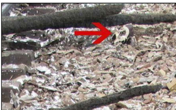
Figur 41: Isolator ved utgangen av østre snøoverbygg.
