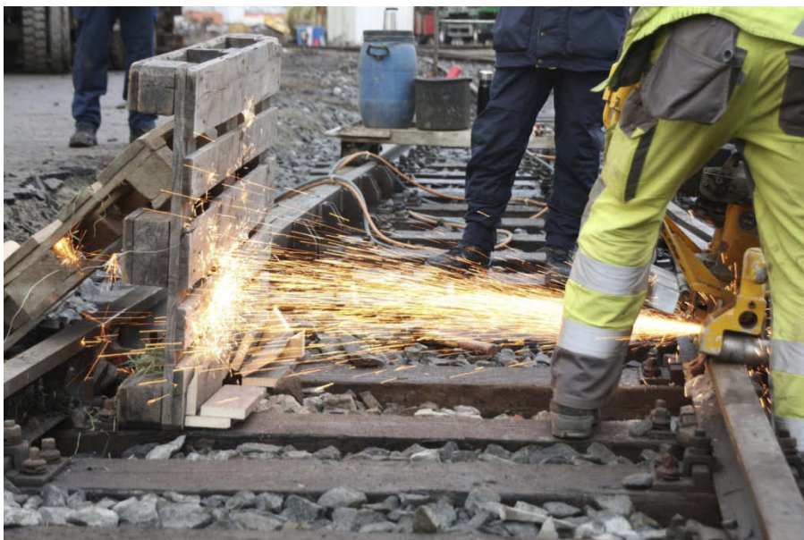
Figur 5-2 Sliping med gnistsprut mot testoppsett.
