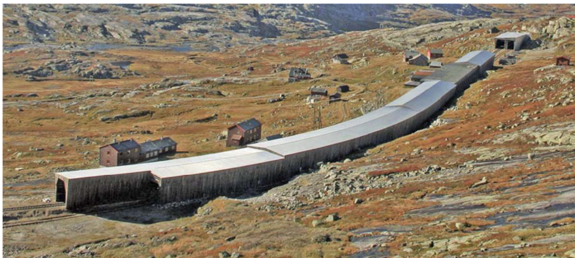
Figur 36: Hallingskeid stasjon og snøoverbygg. (Foto: Willy Koch - 2007)
