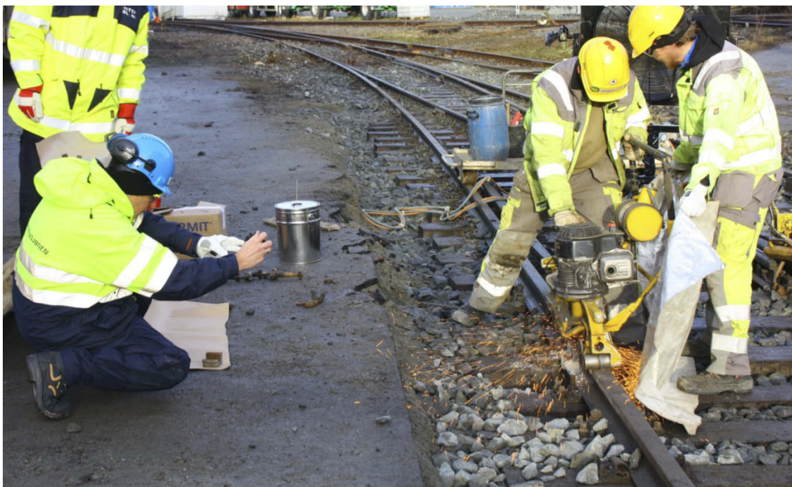
Figur 5-1 Skinnesveising under simulerte forhold fra Hallingskeid. Vindmaskinen er synlig i bakkant av skinnesveiserne.
