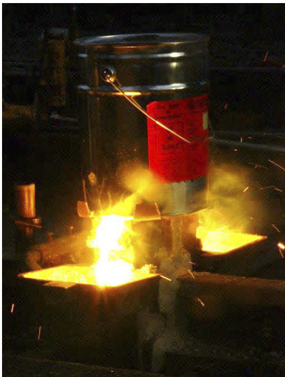
Figur 5-7 Flytende varmt materiale fra termitt-sveis.
