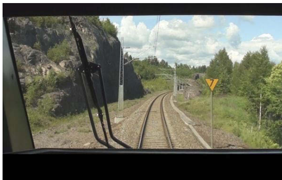
Figur 18: Hastighetssignalet for 70 km/t (foto: SHT).
