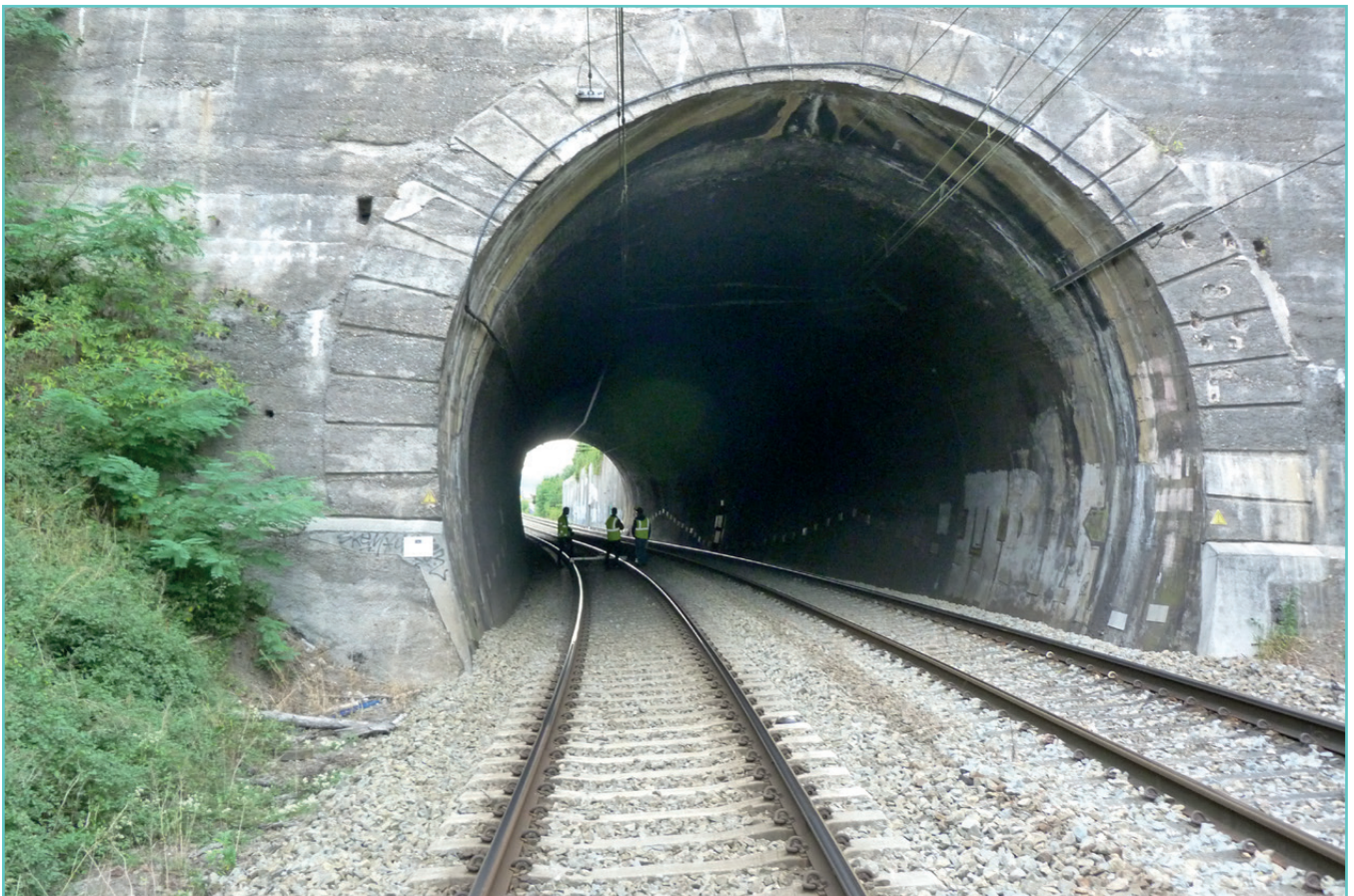
Entrée du tunnel : le jour de l'accident, le train roulait sur la voie située à gauche sur la photo.
