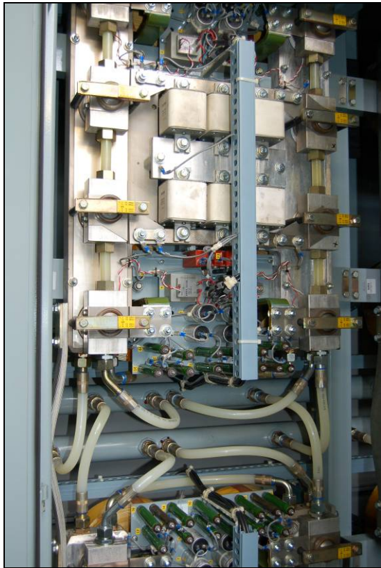
Figur 8 Modifisert løsning for plastslanger og koblinger.
