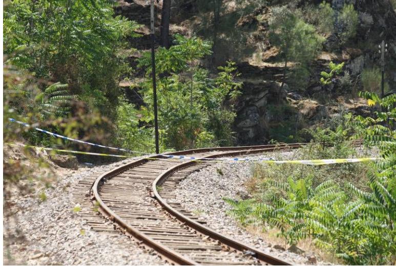
Foto 1 – Aspecto geral da via no local do acidente
