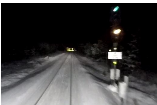
Figur 10: Innkjørhovedsignal A, forsignal L/N. Foto: SHT
