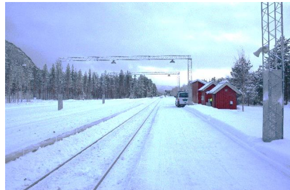
Figur 4: Atna stasjon retning Koppang (Sør). Foto: SHT
