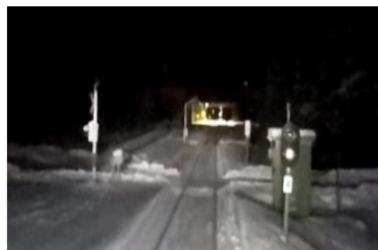
Figur 11: Planovergang med signal W1. Foto: SHT
