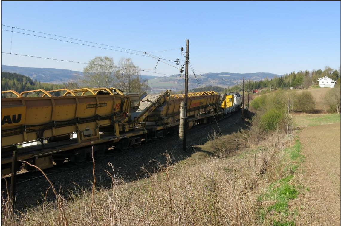
Figur 6: Kontaktledningsmast. Foto: SHT
