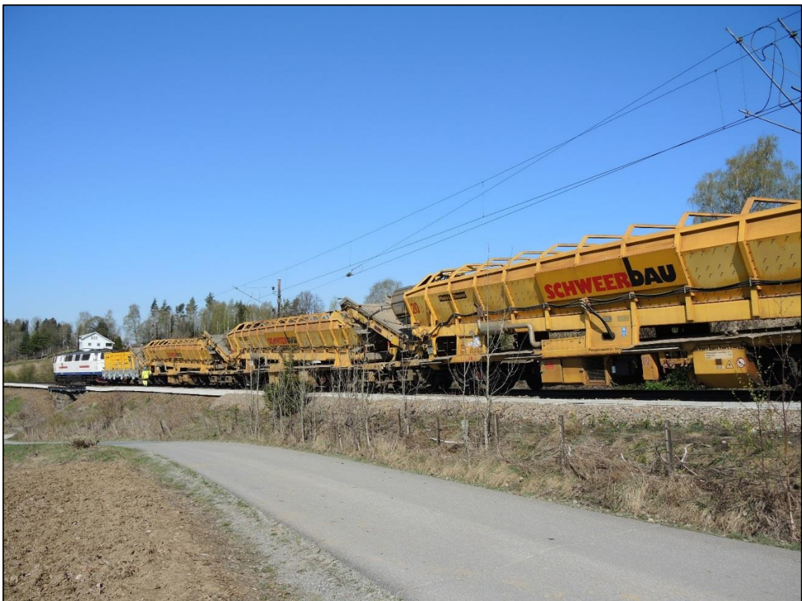
Figur 2: Parkert ballastrenseverk ved ulykkesstedet. Foto: SHT
