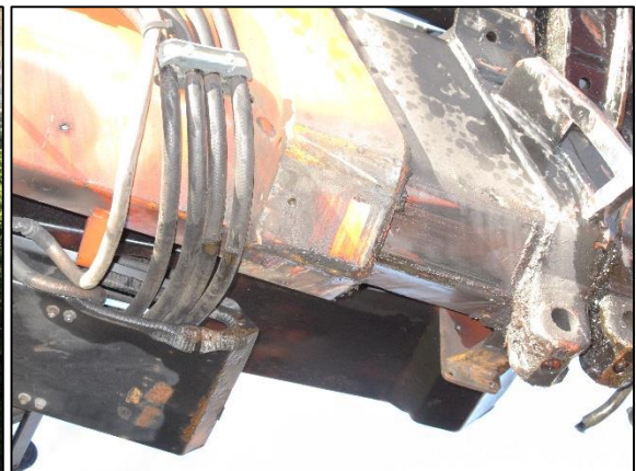
Figur 8: Merker på kranarm etter kontakt med holdebraketten. Foto: SHT
