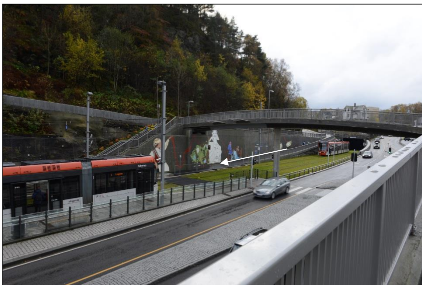
Figur 3: Den hvite pilen viser gangveien og retningen vedkommende kom gående mot holdeplassen. Foto: SHT
