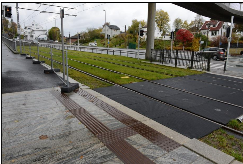
Figur 8: Tilrettelagt kryssing av sporet. Det midlertidige ledegjerdet som vises på bildet ble satt opp etter ulykken. Foto: SHT
