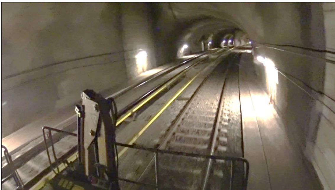
Figur 17: Bilde fra stedet hvor ledningsbilen mistet kontroll på bremsene. Ledningsbilen var på venstre spor, motsatt spor av hvor bildet er tatt. Foto: Sporveien Oslo AS
