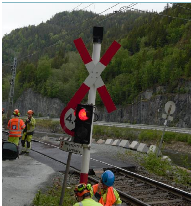
Figur 23: Rød lampe i veisignal V1 lyste da bilbatteri ble tilkoblet. Foto: SHK
