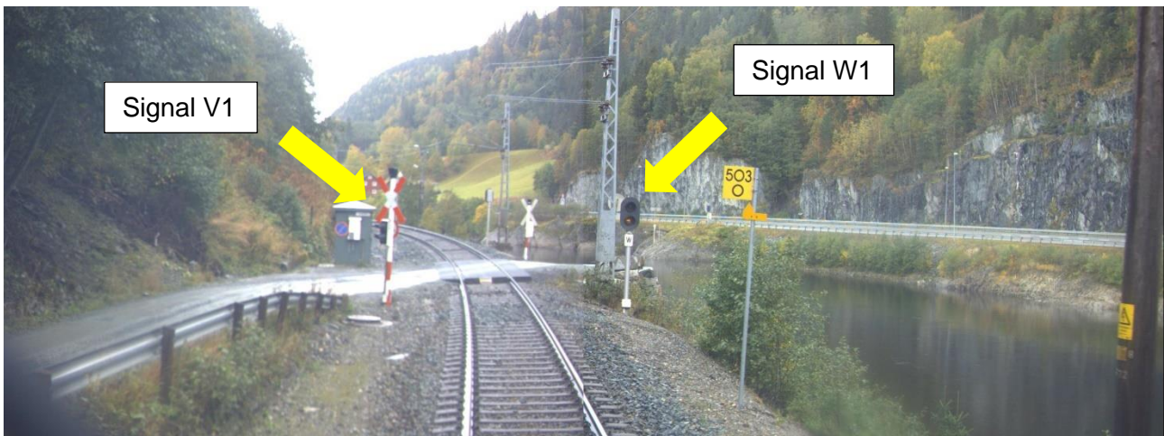
Figur 19: Hagamælen planovergang sett fra Bane NORs målevogn. Foto: Bane NOR SF med markeringer av SHK
