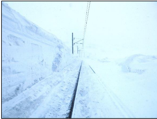
Figur 6: Skjæringen i området hvor tog 5502 sporet av. Foto: SHT
