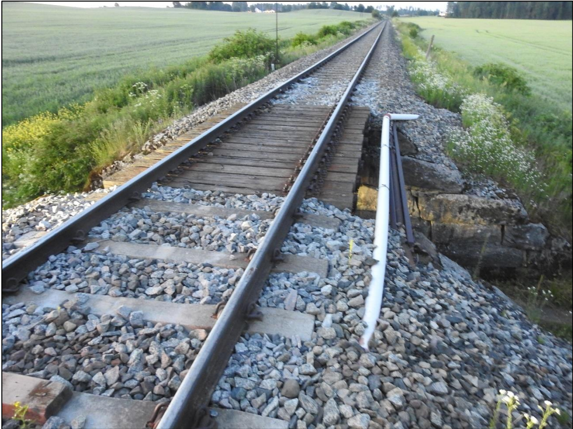
Figur 8: Stålbrua ved staden der lokomotivet spora av. Foto: SHK
