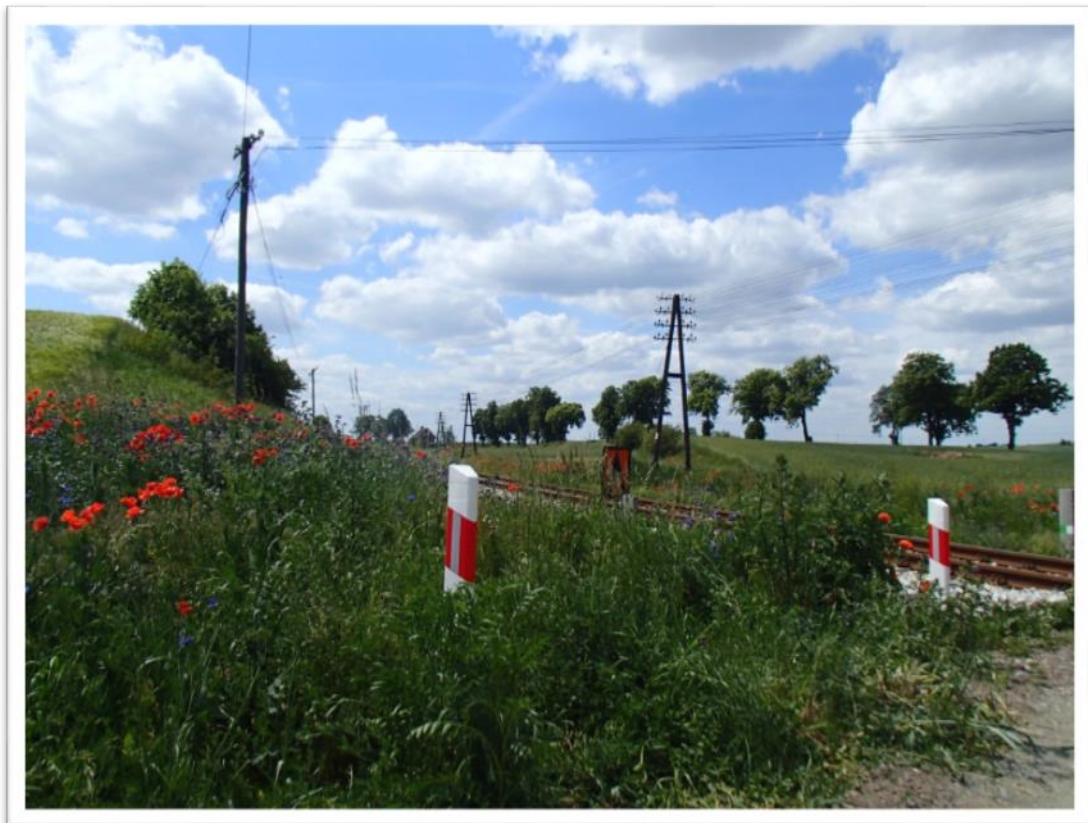
Widok z odległości 5 metrów .
