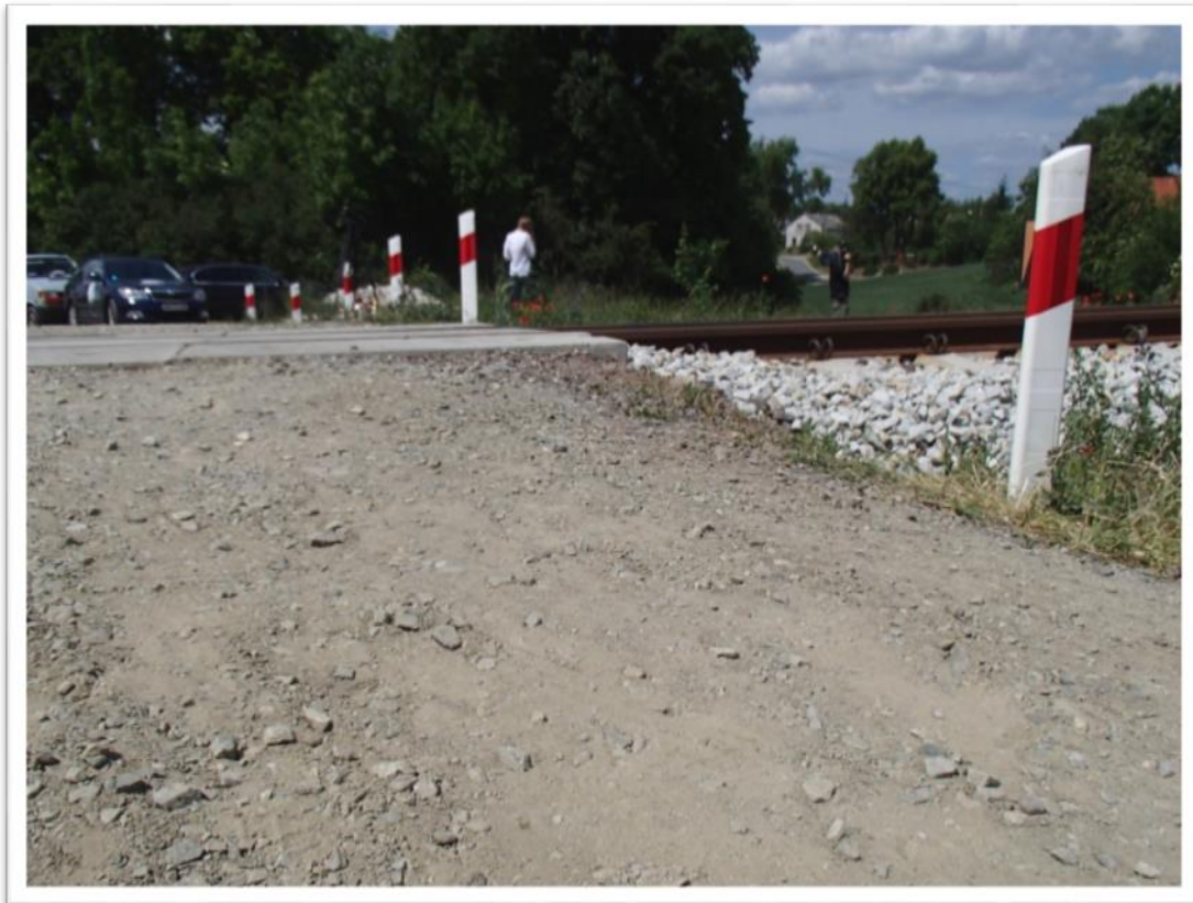
Nawierzchnia drogi dojazdowej gruntowa – kruszywo łamane.
