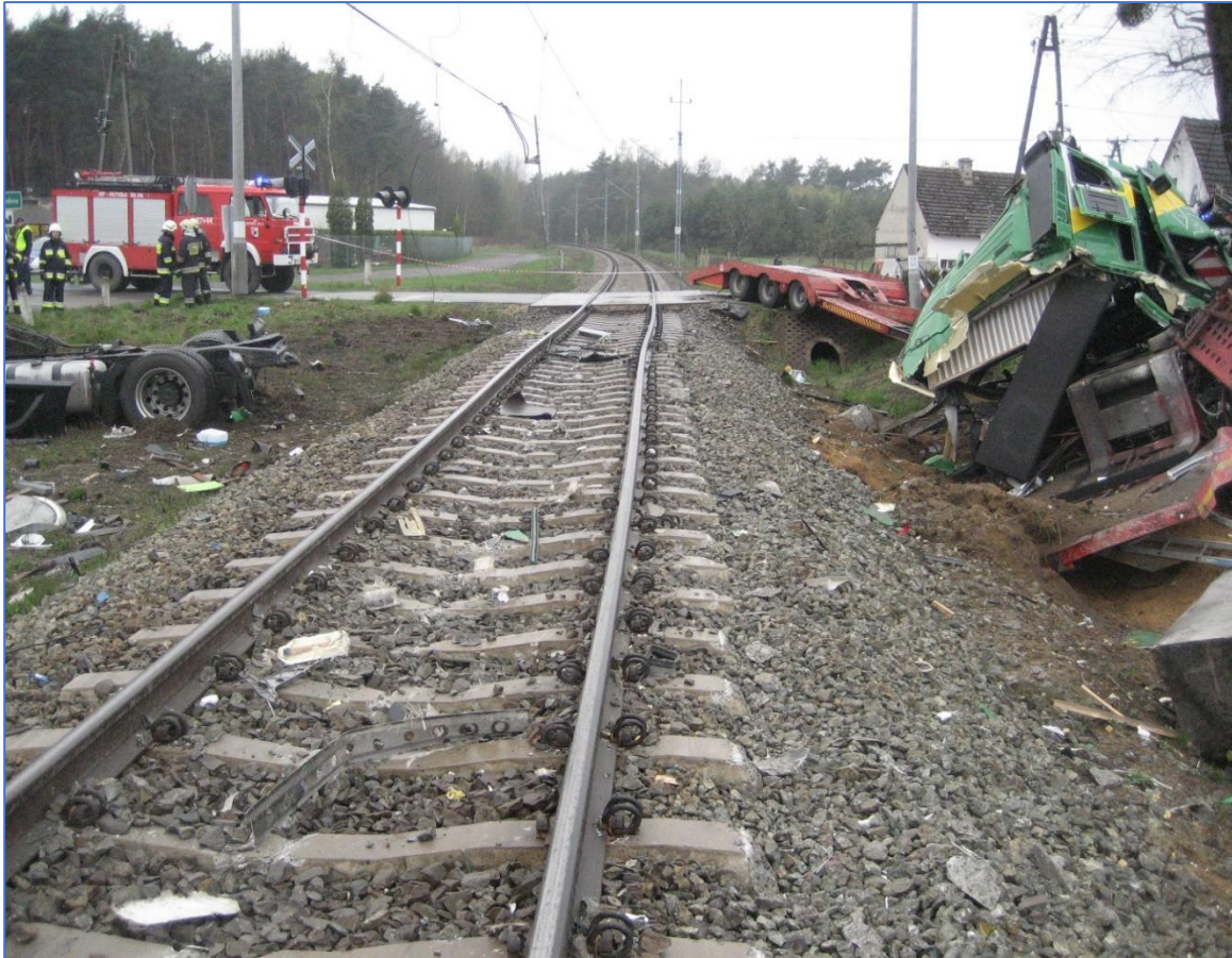
Fot. 7. Widok rozbitej lawety na przejeździe kategorii C
