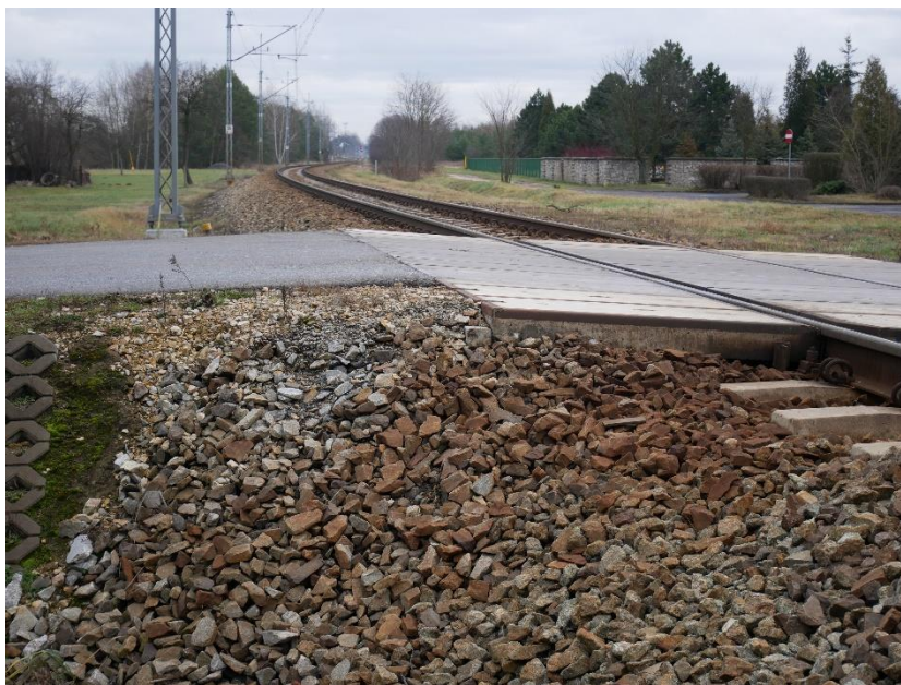
Fot. 19, 19a. Widok przejazdu po rewitalizacji
