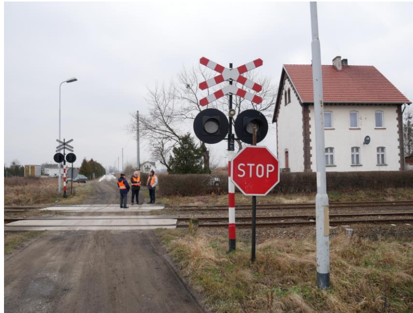
Samoczynna sygnalizacja przejazdu SPA-2, kat. „C”
