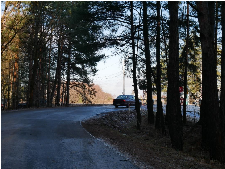
Zdjęcie 12 - Widoczność sygnalizatorów drogowych z przeciwnej strony przejazdu (material PKBWK)
