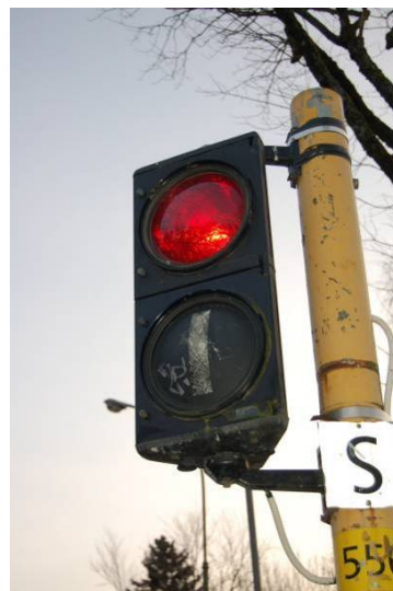
Figur 8 og 9: Signal S 556 var plassert unormalt langt til siden for trikkens høyre side. Dette skyldts at signalet var plassert på utsiden av plattformen. Signalet manglet skyggeskjermer, og var i tillegg dårlig retningsjustert.
