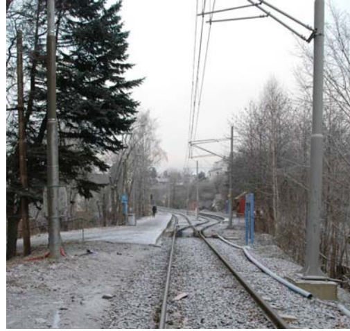
Figur 5: Sæter holdeplass sett fra Sæter bru, mot Oslo.
