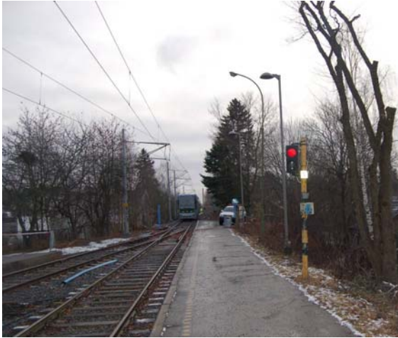
Figur 4: Overgangen til enkeltspor og inngangen til Sæter bru. I fremkant ses signal S 556 som regulerer kjøringen inn på den enkeltsporede strekningen.
