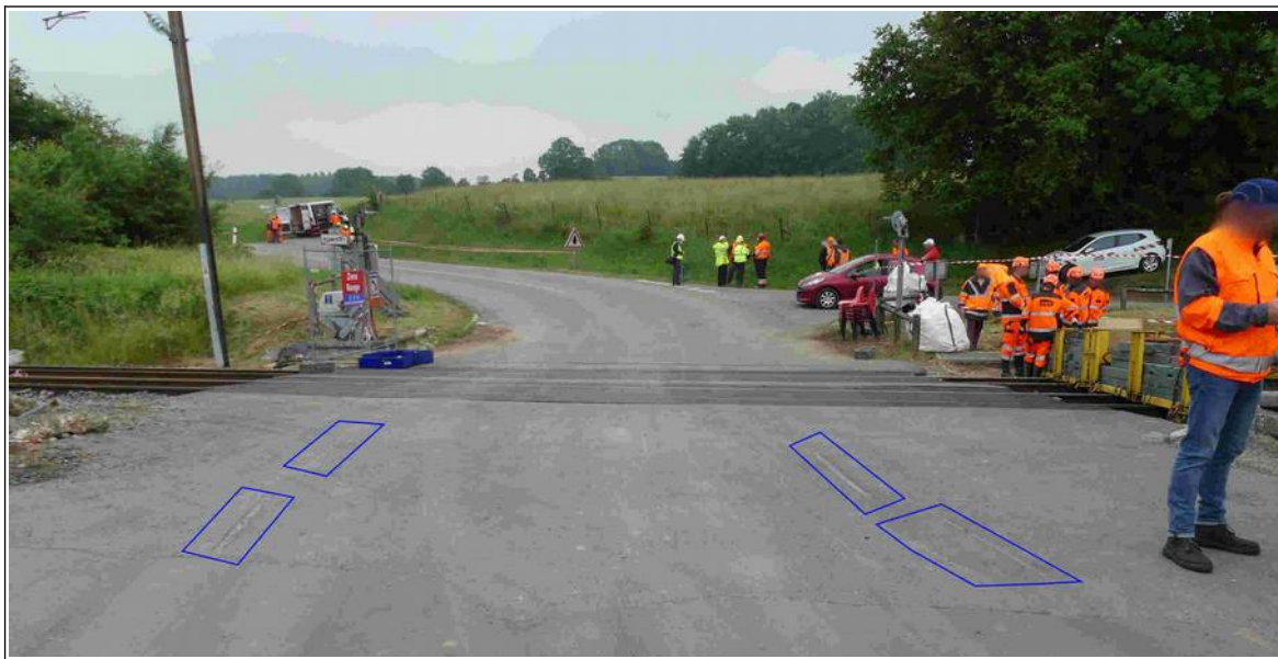
Figure 9 : illustration du revêtement de la RD 27 à proximité du PN n° 17 source BEA-TT
