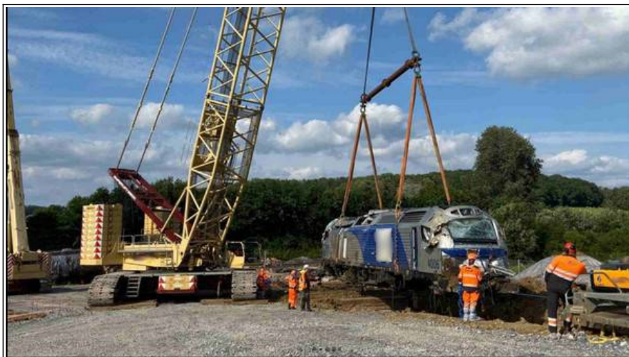
Figure 45 : opérations spécifiques de relevage de la motrice photo SNCF Réseau
