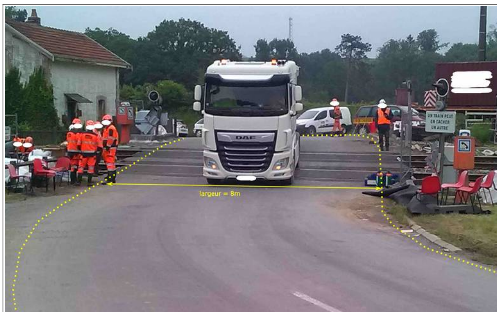
Figure 7 : illustration du profil en travers de la RD 27 à proximité du PN n° 17 source BEA-TT
