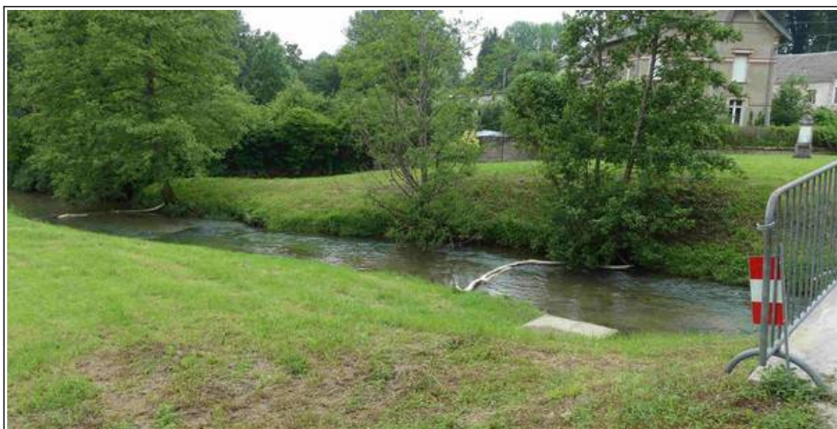
Figure 46 : barrages mis en place sur la rivière
