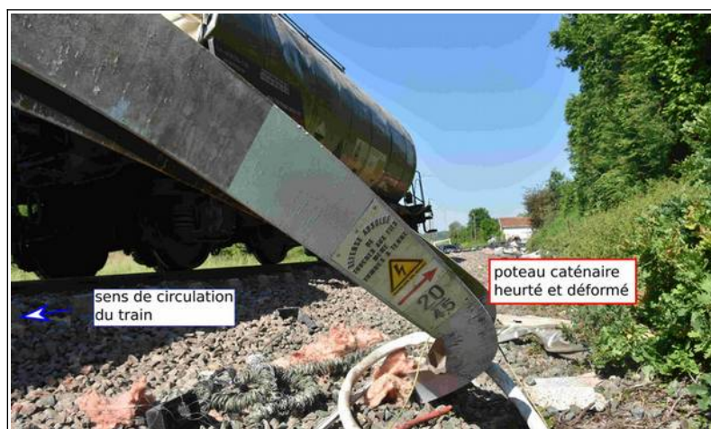
Figure 21 : état des lieux : les dégâts aux infrastructures ferroviaires, exemple d'un poteau caténaire photo Gendarmerie Nationale, légende BEA-TT
