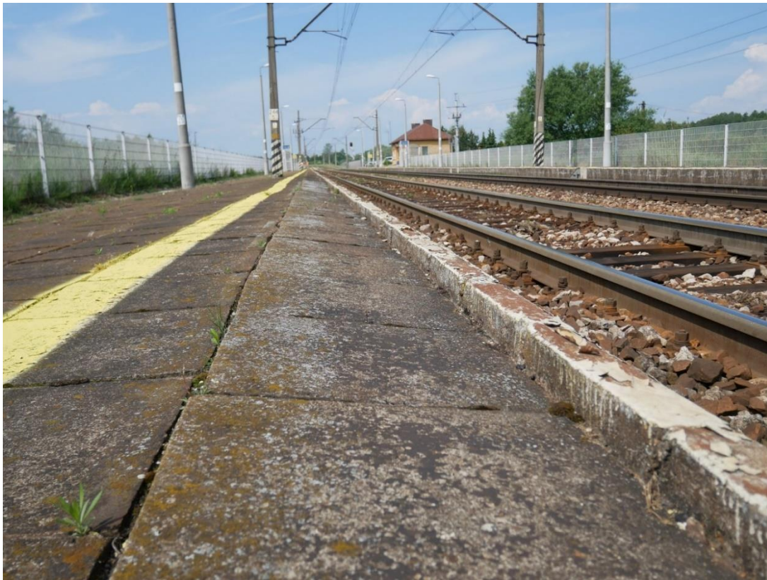
Zdjęcie 11 - Widok na Peron 2 z nierównościami nawierzchni (materiał własny PKBWK).
