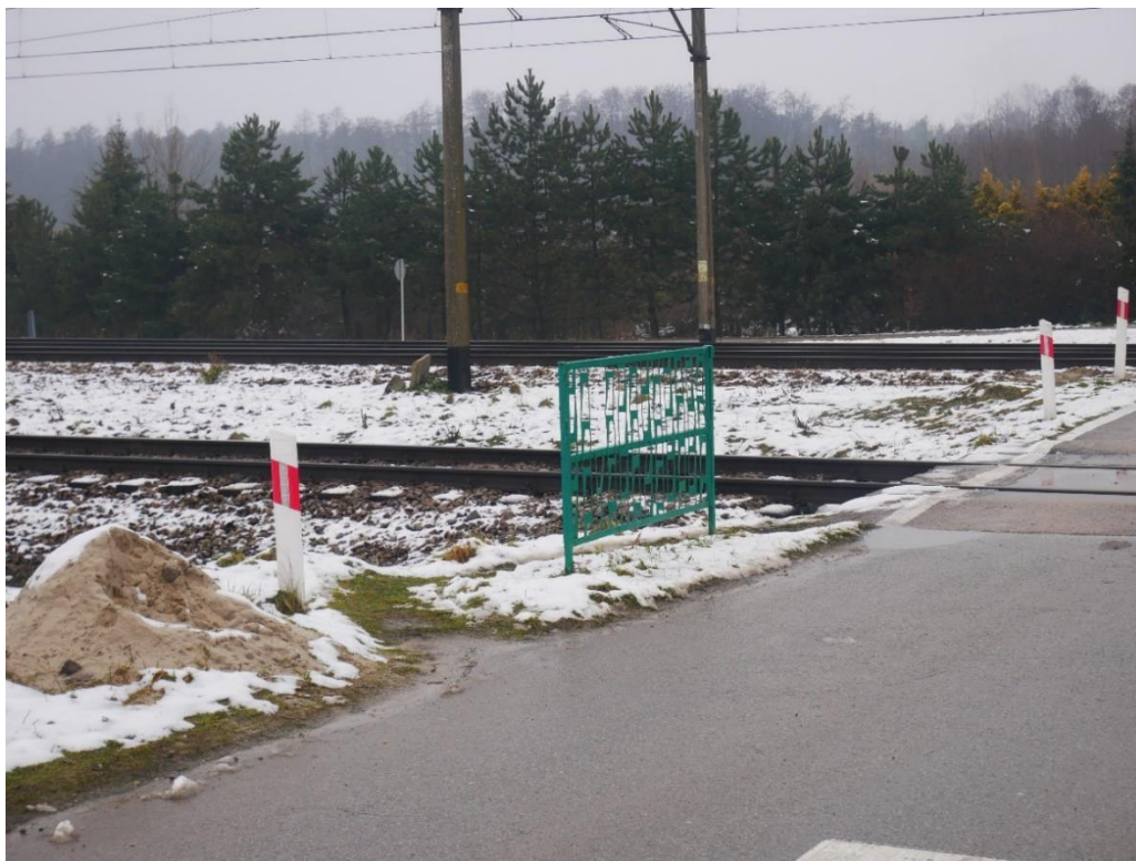
Zdjęcie 10 - Widok na przejazd kat. A km 244,630 z wygradzeniem (materiał własny PKBWK).
